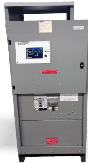
El DCR de AMETEK Solidstate Controls es un sistema controlado por microprocesador, basado en tiristor, diseñado para la conversión de alta eficiencia de la alimentación de CA comercial de entrada en alimentación de CC limpia. Se utiliza para cargar baterías mientras se suministra energía a cargas de CC continuas como los inversores.
